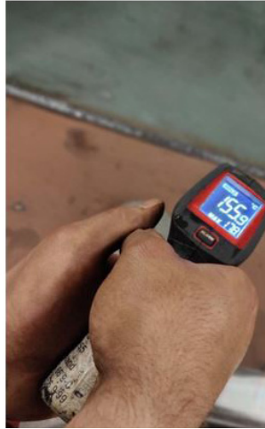
Hitsaaja mittaa lämpötilan huulilevyn yläpuolelta.
