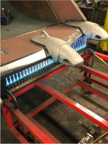
Kaivurikauhan, huulilevyn ja kynnen esikuuminen. Esikuuminen levyn alapuolelta varmistaa sen, että huulilevy tulee kuumennetuksi koko paksuudeltaan.
